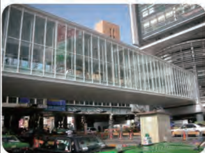
渋谷駅東口渡り廊下 スチール窓枠 フッ素樹脂粉体塗装
