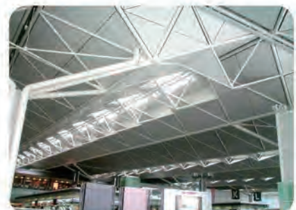
中部国際空港 天井スチールパネル ポリエステル樹脂粉体塗装
