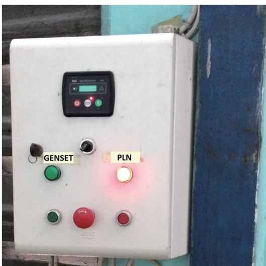
倉庫の空調用電源は通常 PLN（国有電力会社）からですが停電時は GENSET（発電機）に切り替えます
