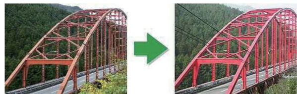
写真5 鋼構造物塗装（橋梁塗装工事）
