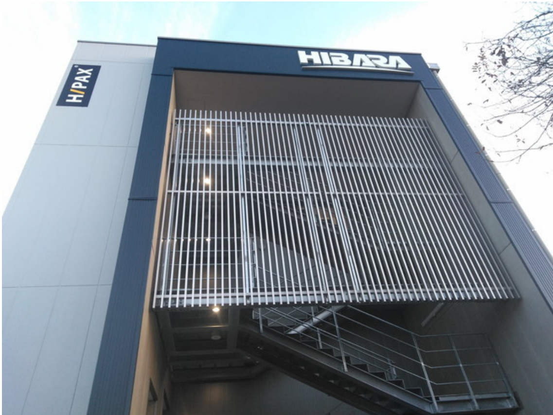
研究開発棟（D棟）外観
