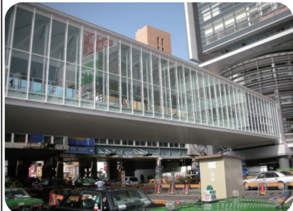
渋谷駅東口渡り廊下 スチール窓枠 フッ素樹脂粉体塗装
