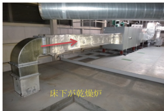
写真 1 乾燥炉排ガス処理・熱回収システム取付け部
