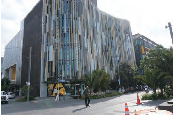
ASB 本部（銀行）の外装材に粉体塗装が採用
