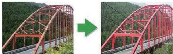
写真5 鋼構造物塗装(橋梁塗装工事)
