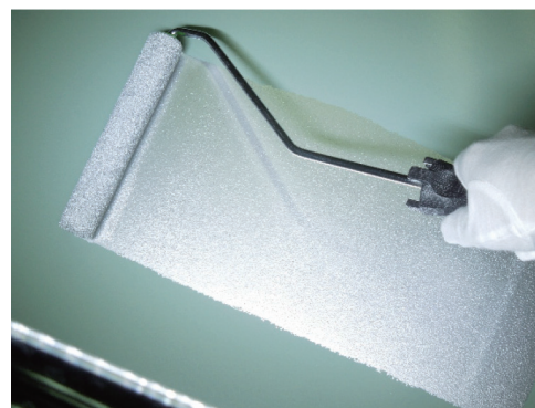
写真1 サーモレジン SV600 のローラー塗装
